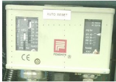
图 2-33: 高、低压力控制器
