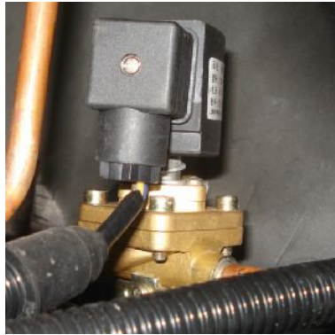
图 2-36: 热气旁通阀
