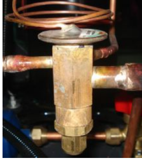
图 2-31: 热力膨胀阀
