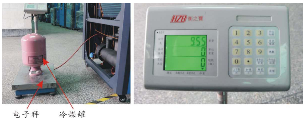
图 6-2: 填充冷媒二
