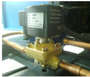
图 2-35: 液管电磁阀
