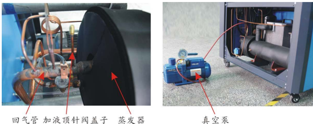
图 6-1: 填充冷媒一
