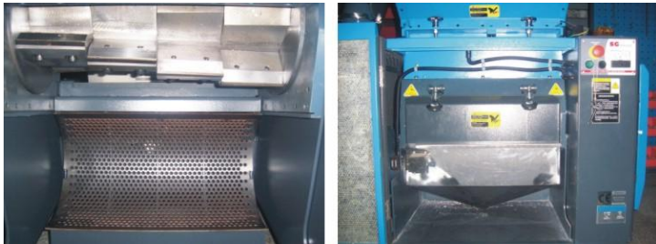
图 3-9: 筛网、筛网架及集料盒安装
