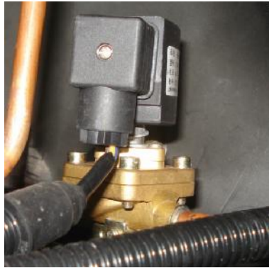
图 2-36: 热气旁通阀
