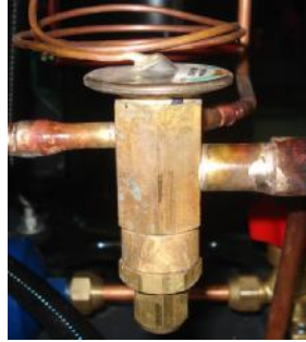
图 2-31: 热力膨胀阀
