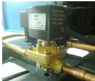
图 2-35: 液管电磁阀
