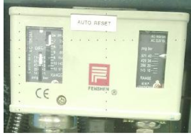
图 2-33: 高、低压力控制器
