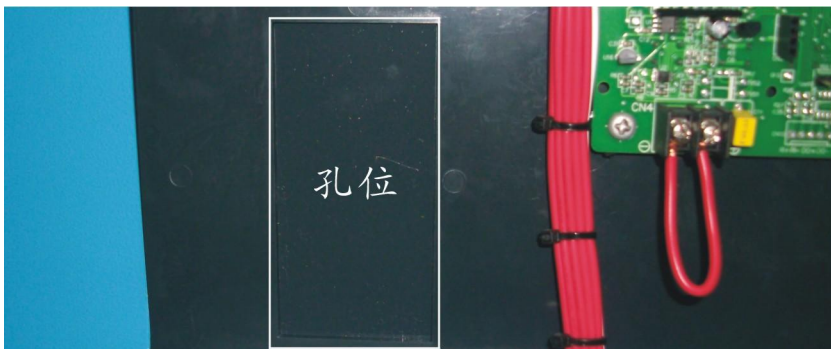
图 3-3: 露点计安装孔位
