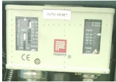
图 2-33: 高、低压力控制器
