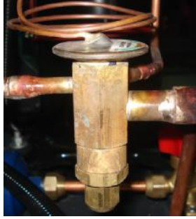
图 2-31: 热力膨胀阀
