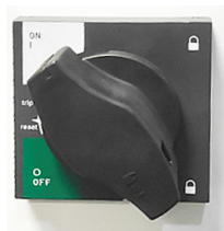
图 2-3: 门联锁开关
