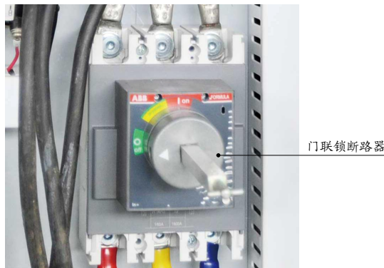
图 2-3: 门联锁断路器
