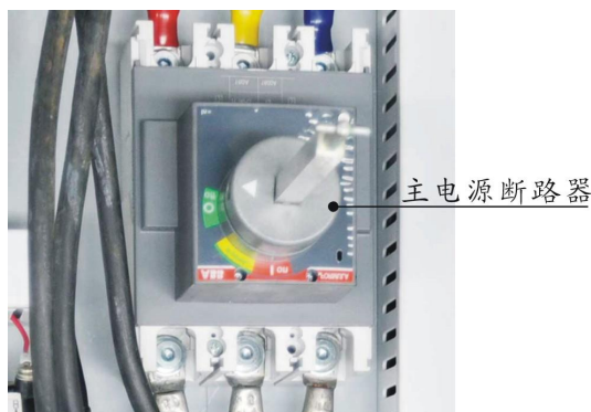
图 4-2: 主电源断路器
