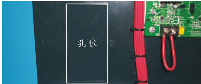
图 6-7: 露点计安装孔位
