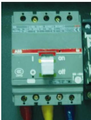
图 4-3: 主电源开关
