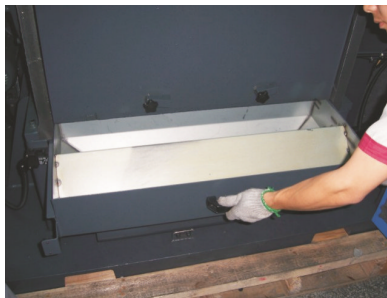
图 6-13：筛网、网架及集料盒安装五
