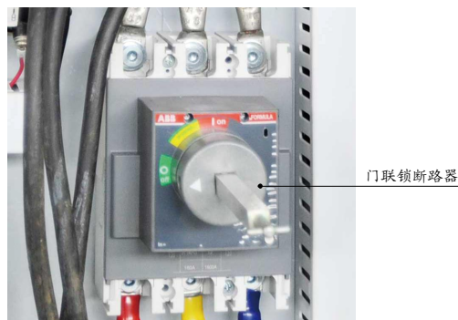
图 2-3: 门联锁断路器
