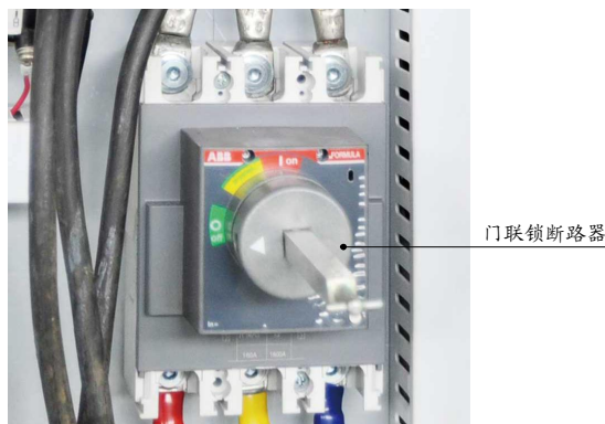
图 2-3: 门联锁断路器
