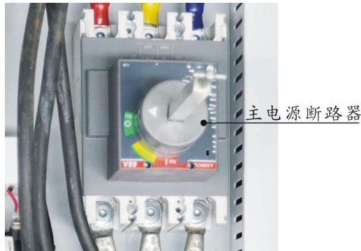
图 4-5: 主电源开关
