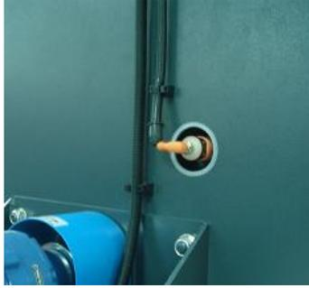
图 4-31: 搅拌桶侧面上的料位开关图
