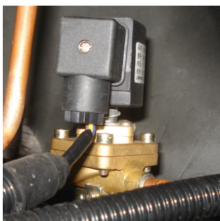
图 2-10: 热气旁通阀
