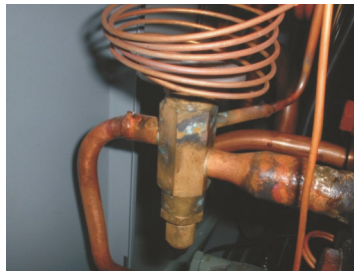
图 2-5：热力膨胀阀
