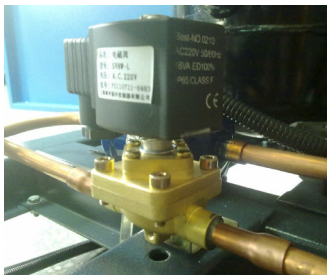
图 2-9: 液管电磁阀
