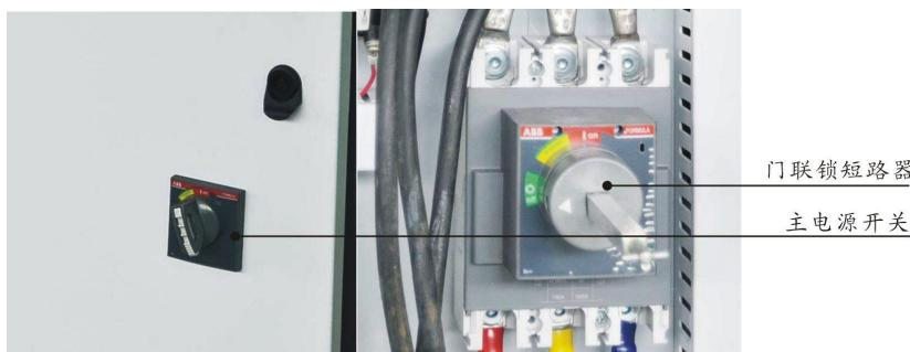
图 4-2: 主电源开关
