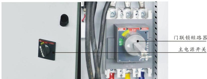
图 4-2: 主电源开关
