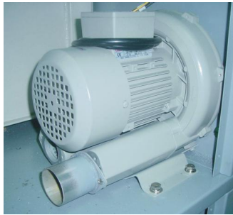
图 6-3: 干燥风机安装图
