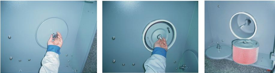
图 5-1: 过滤器清洗图
