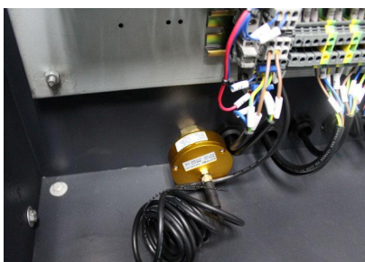
图 2-6: 安装露点计变送器
