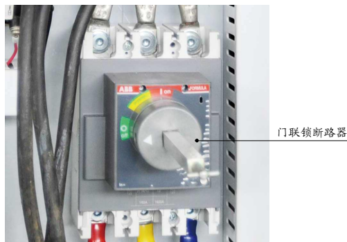
图 2-3: 门联锁断路器
