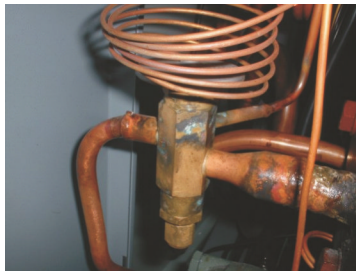
图 2-5：热力膨胀阀
