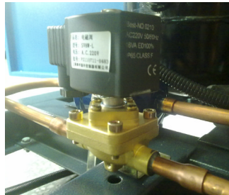
图 2-10: 液管电磁阀
