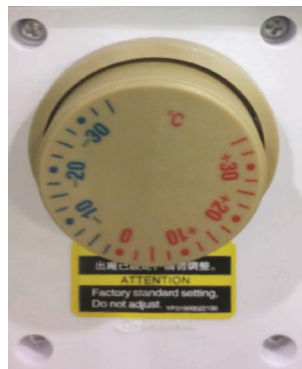
图 3-15: 压缩机防冻开关
