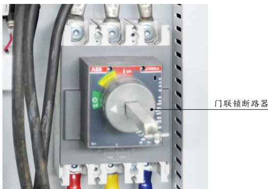
图 2-3: 门联锁断路器
