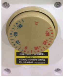
图 3-9: 压缩机防冻开关
