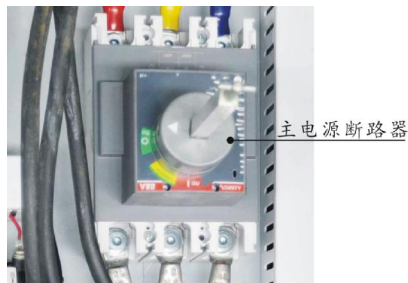
图 4-2: 主电源断路器
