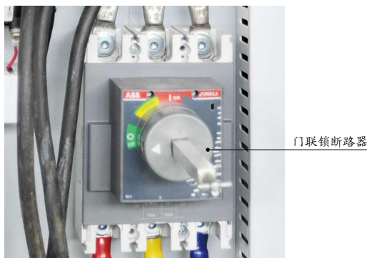
图 2-3: 门联锁断路器
