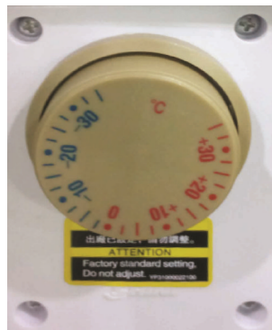
图 3-15: 压缩机防冻开关
