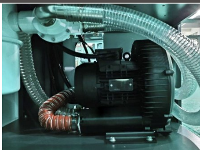
图 6-4: 吸料风机安装图
