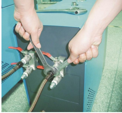
图 3-2: 管路的连接一
