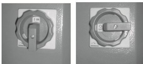
图 3-3: 主电源开关
