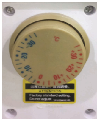
图 3-15: 压缩机防冻开关
