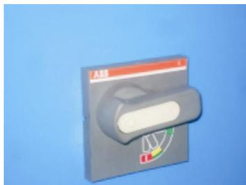
图 4-4: 主电源开关
