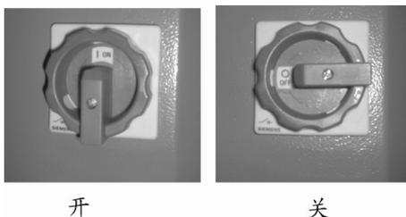
图 4-3: 主电源开关
