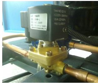
图 2-44: 液管电磁阀
