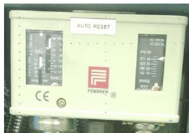
图 2-42: 高、低压力控制器
