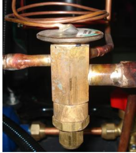
图 2-40: 热力膨胀阀
